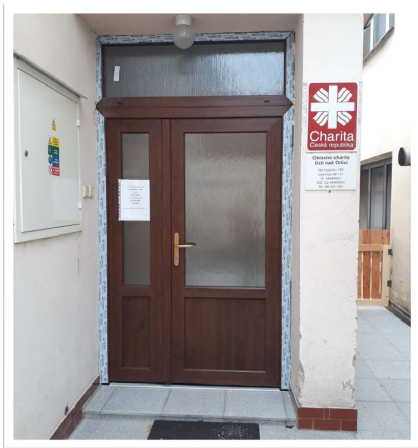
Oprava vstupního prostoru správního střediska OCHUO
