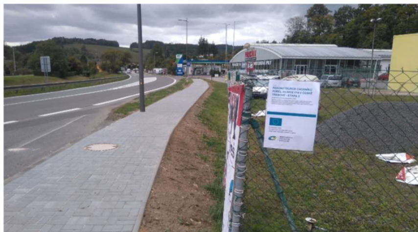
Rekonstrukce chodníků podél silnice I/14 v České Třebové
